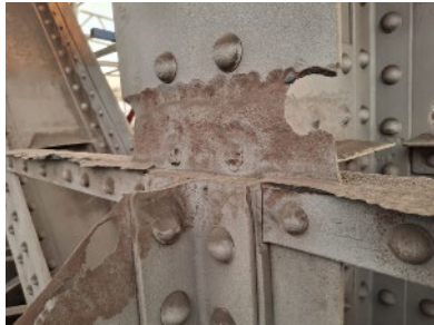
Corrosion importante (voire totale) de la structure
