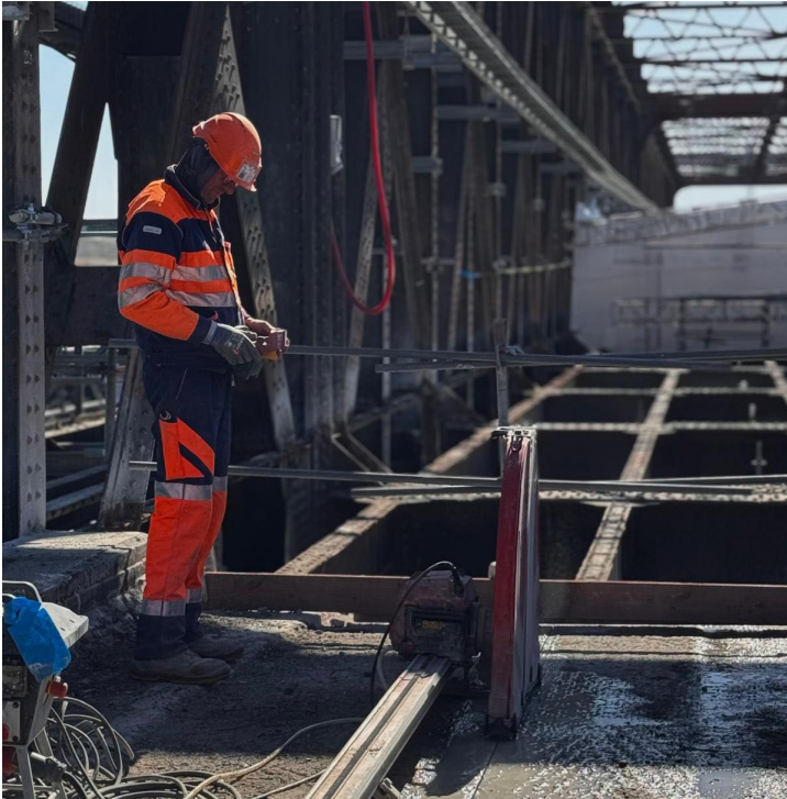
7000m de sciage à réaliser Achat d'une scie murale Hilti pour réaliser les travaux en Part Propre
