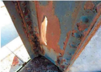
Corrosion importante (voire totale) de la structure
