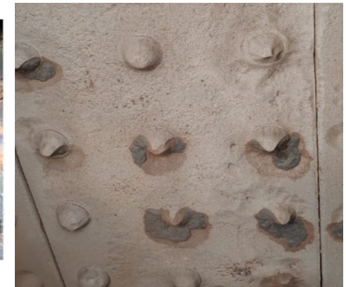
Détérioration / Corrosion des rivets
