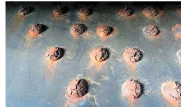
Détérioration / Corrosion des rivets
