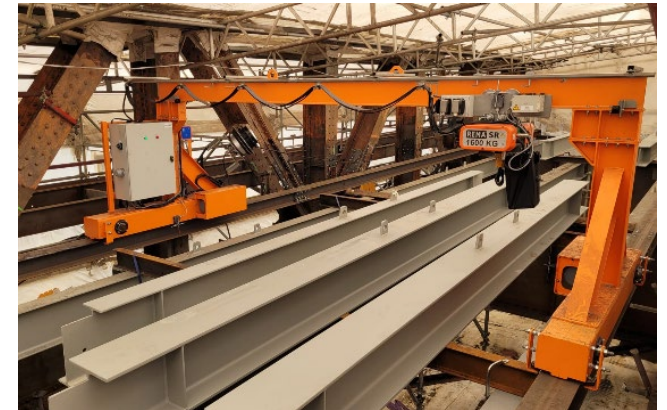
Pose des nouveaux longerons
