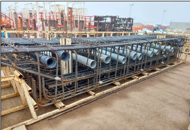
2. Sous-élément assemblé – Dalle supérieure
