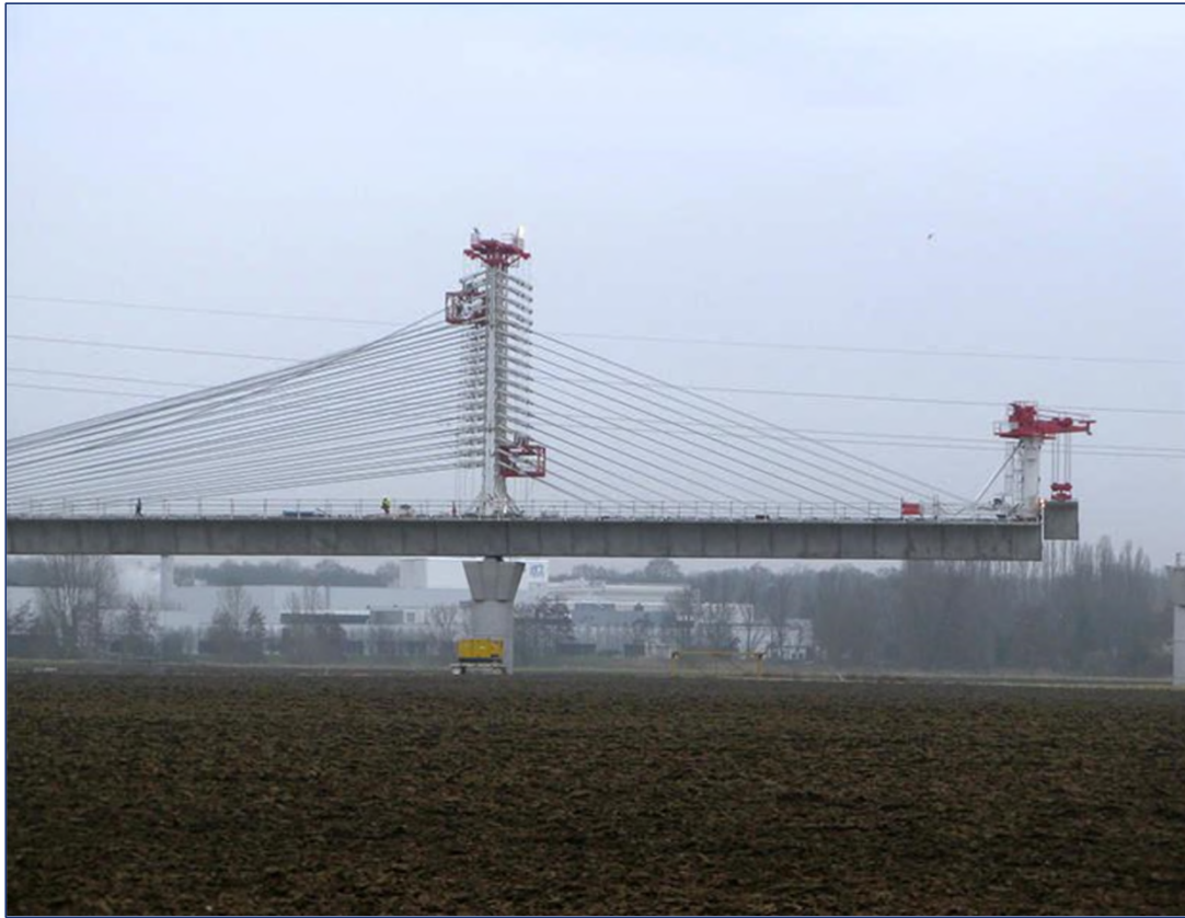
Viaduc autoroutier de Compiègne, France, portée = 57m (2007-2009)
