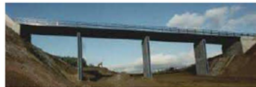
(b) Dalle pleine de béton précontraint (PSIDP)
