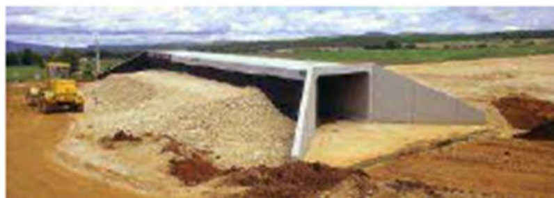
(a) Cadre fermé de béton armé (PICF)
